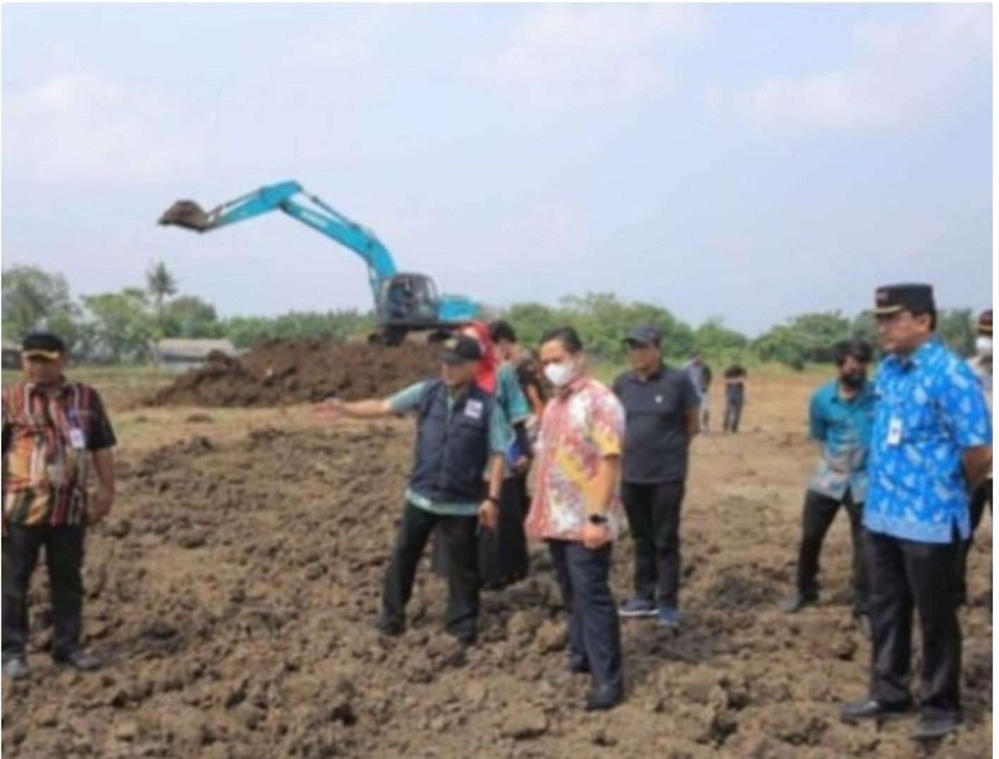
Wali Kota Tangerang Arief R Wismansyah, meninjau pembangunan venue arena Grasstrack
